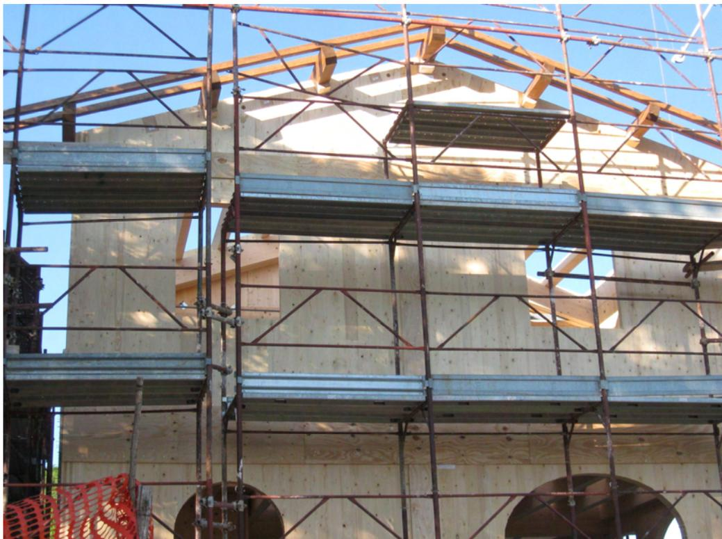
**Figura 53 – Posa e fissaggio delle travi e dei travetti della copertura.**
