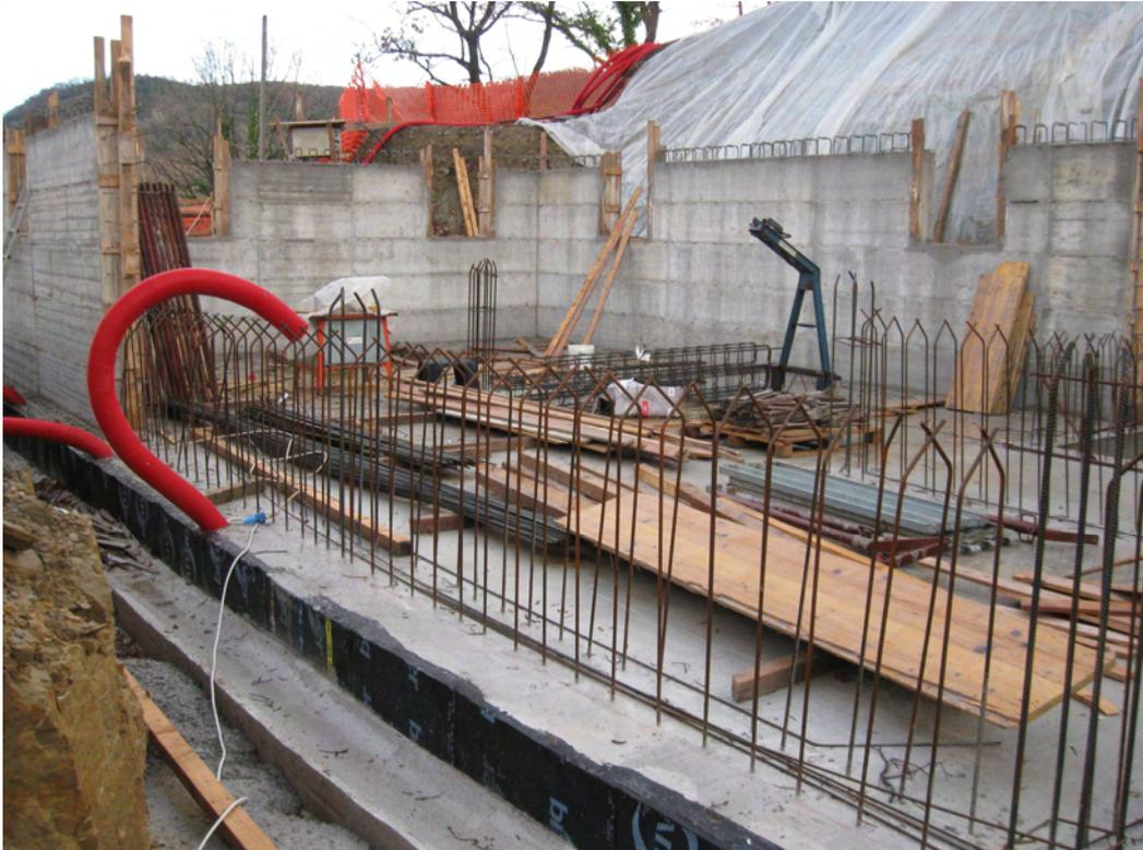
**Figura 40 – Solaio piano interrato e muri controterra.**
