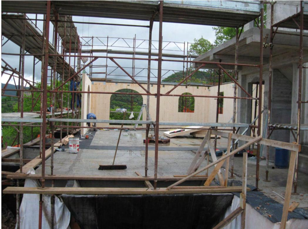
**Figura 46 – Posa e fissaggio dei pannelli in legno al piano terra.**
