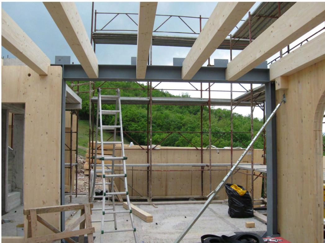
**Figura 49 – Fissaggio delle travi in legno alla trave in acciaio.**
