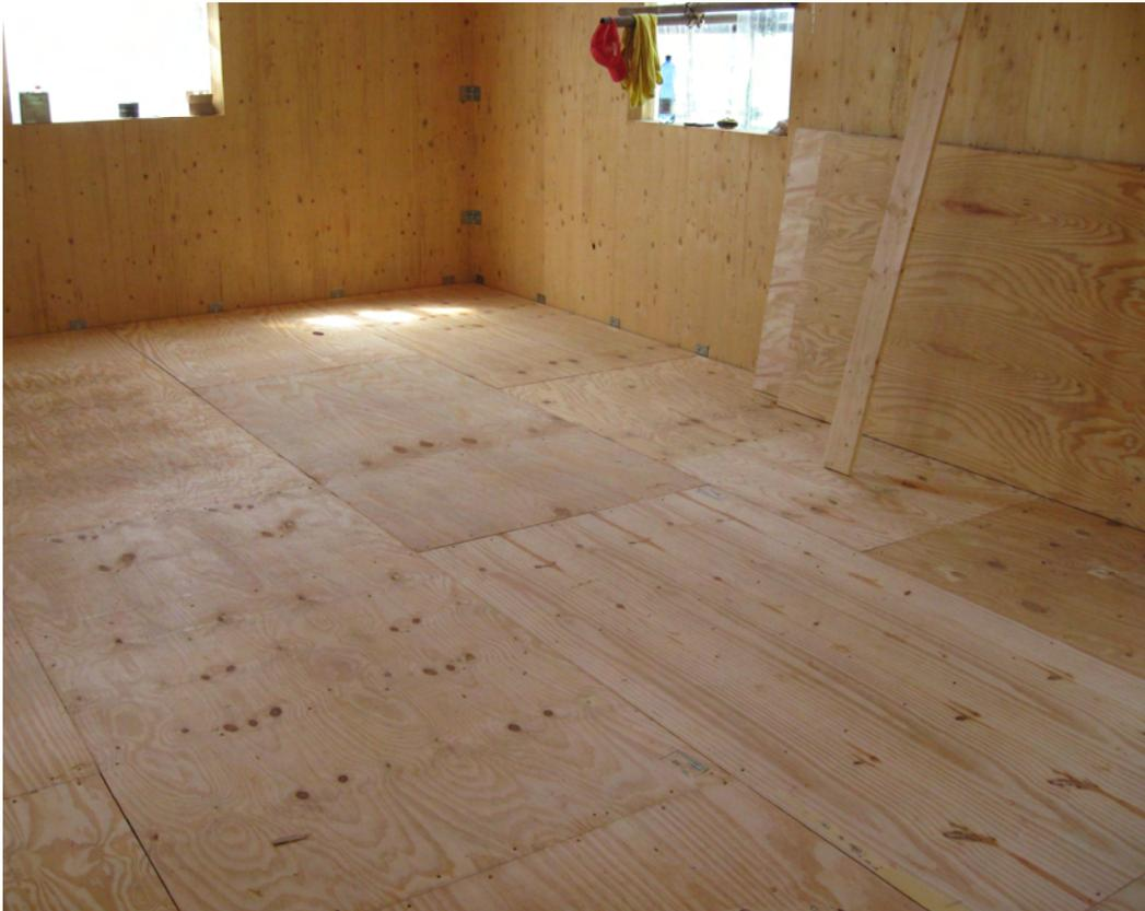
**Figura 56 – Posa dello strato base del solaio del piano primo.**
