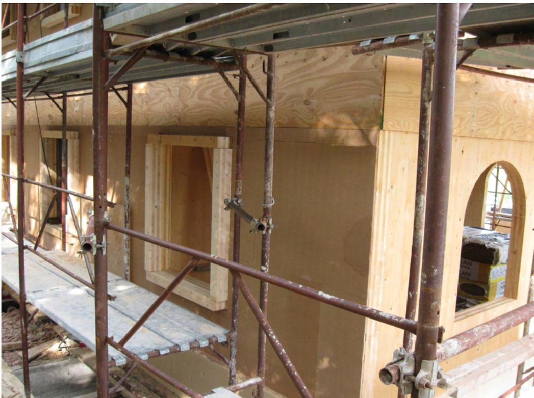
**Figura 57 – Completamento fori per serramenti.**
