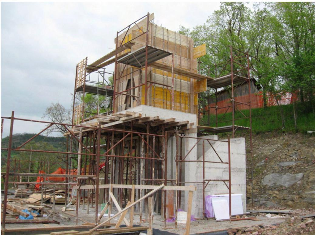
**Figura 45 – Cassaforma dell'ultimo tratto del vano ascensore.**
