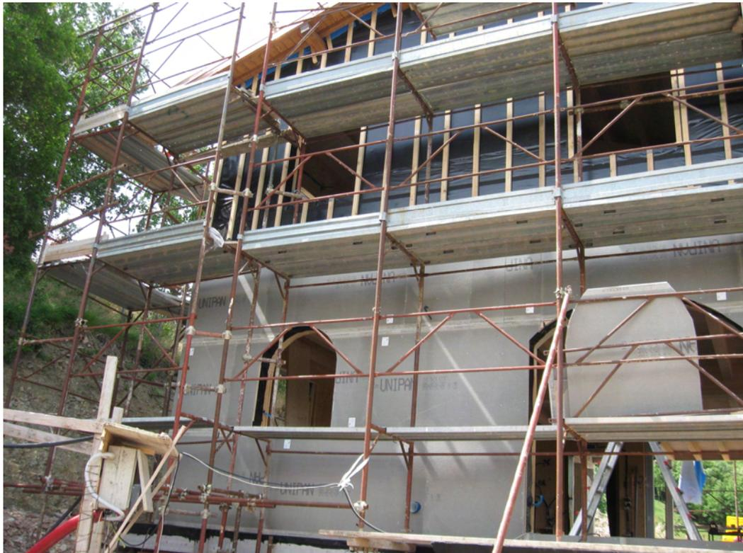
**Figura 60 – Posa del materiale isolante esterno in fibra di legno.**
