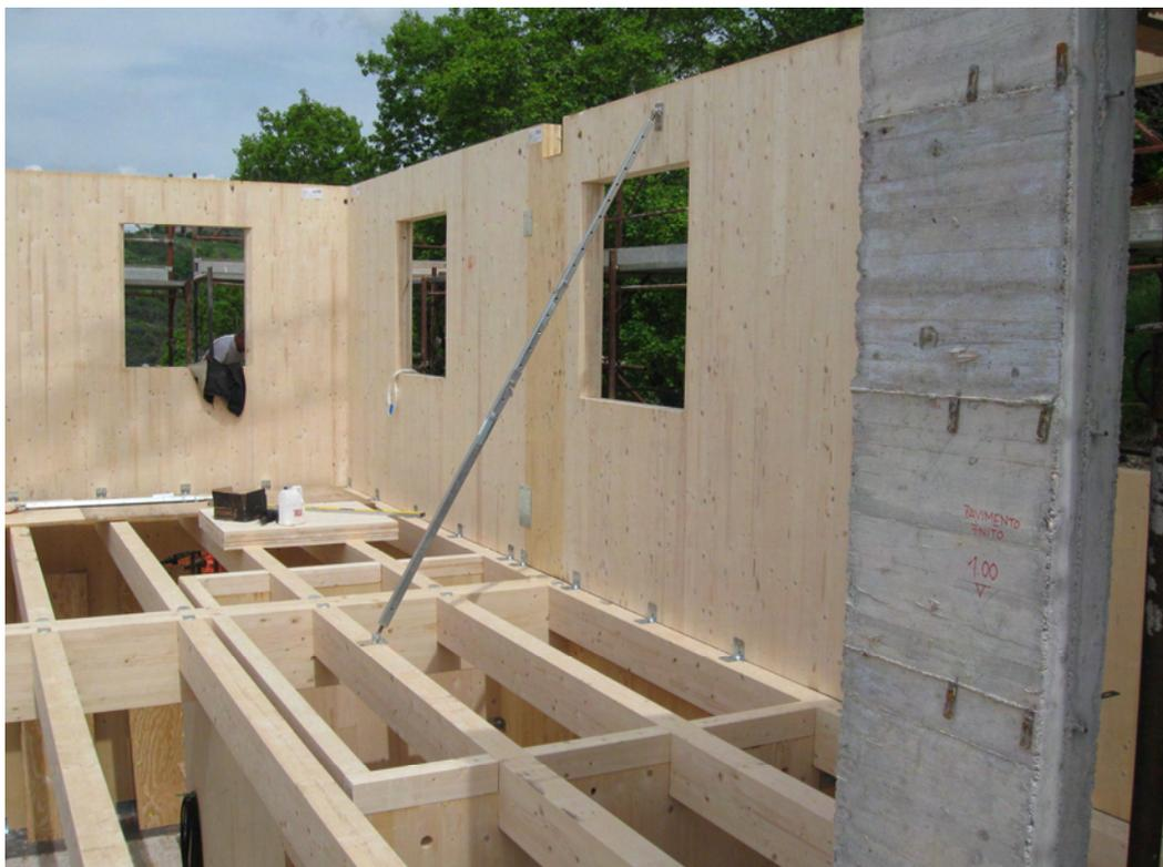
**Figura 51 – Completamento solaio e pareti del piano primo.**
