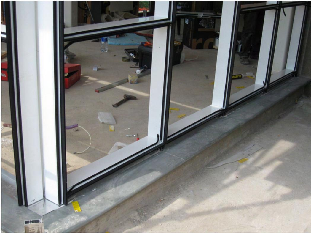
**Figura 66 – Intelaiatura in acciaio per la vetrata della serra solare.**
