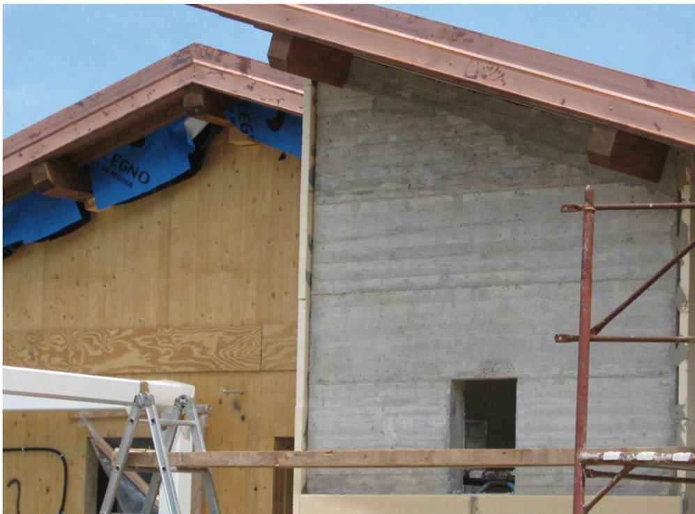
**Figura 59 – Completamento vano ascensore e copertura.**
