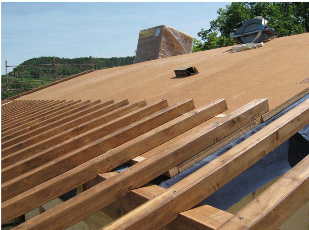
**Figura 55 – Travetti terminali copertura.**
