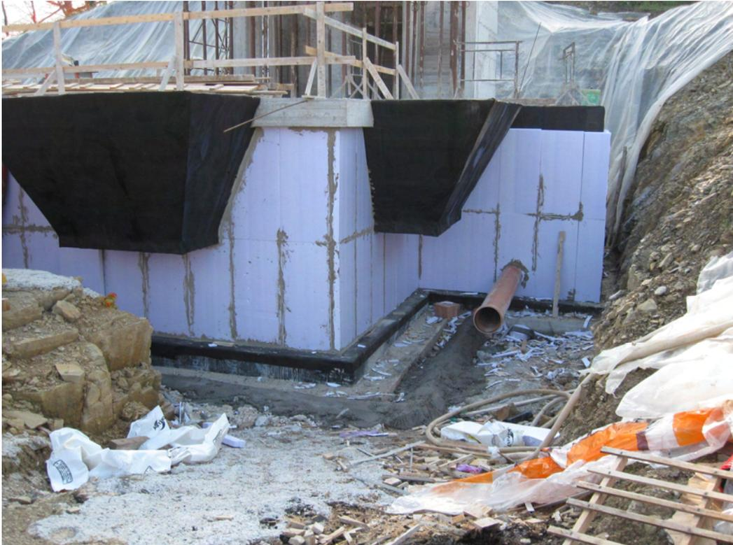
**Figura 44 – Rifinitura ed isolamento esterno del piano interrato.**
