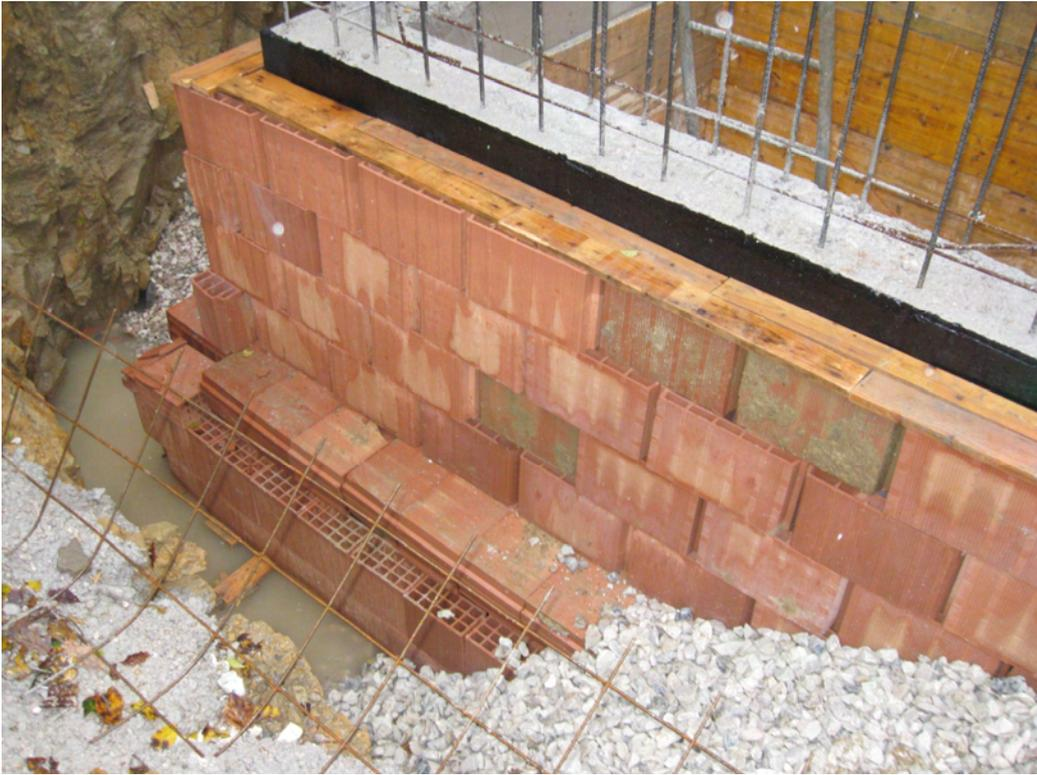
**Figura 38 – Strato in laterizio esterno al muro controterra.**
