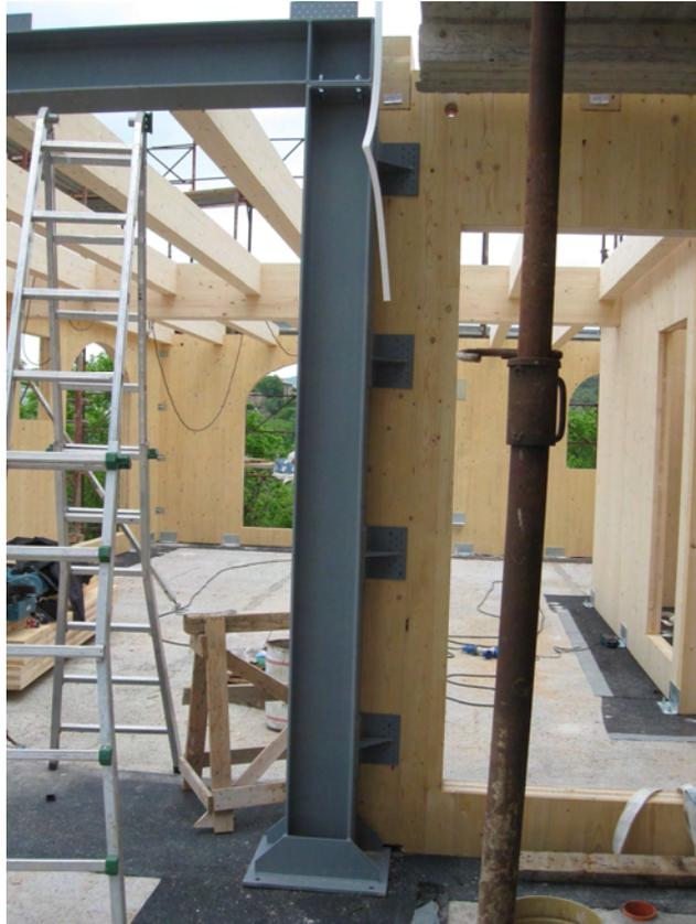
**Figura 48 – Posa e fissaggio delle travi in acciaio della serra solare.**
