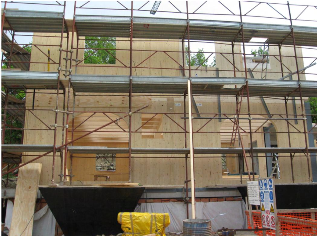
**Figura 50 – Posa e fissaggio dei pannelli in legno del piano primo.**
