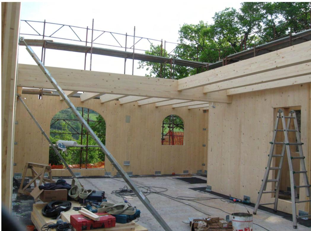
**Figura 47 – Posa travi in legno a vista del solaio del piano primo.**
