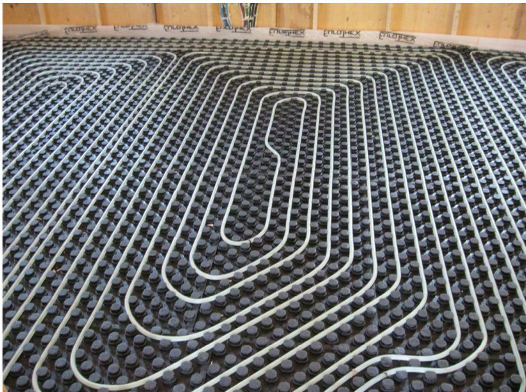
**Figura 63 – Posa del riscaldamento a pavimento.**
