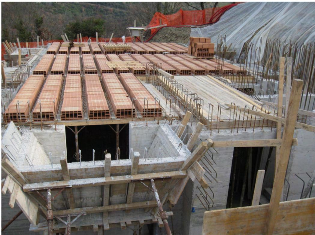
**Figura 43 – Posa pignatte solaio del piano terra.**
