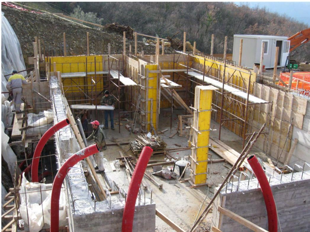
**Figura 41 – Completamento pareti e pilastri del piano interrato.**
