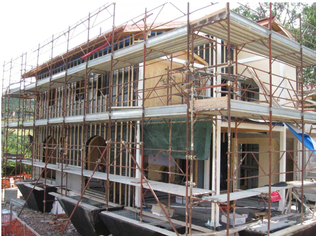
**Figura 61 – Posa della base per la facciata esterna e intelaiatura in acciaio della serra solare.**
