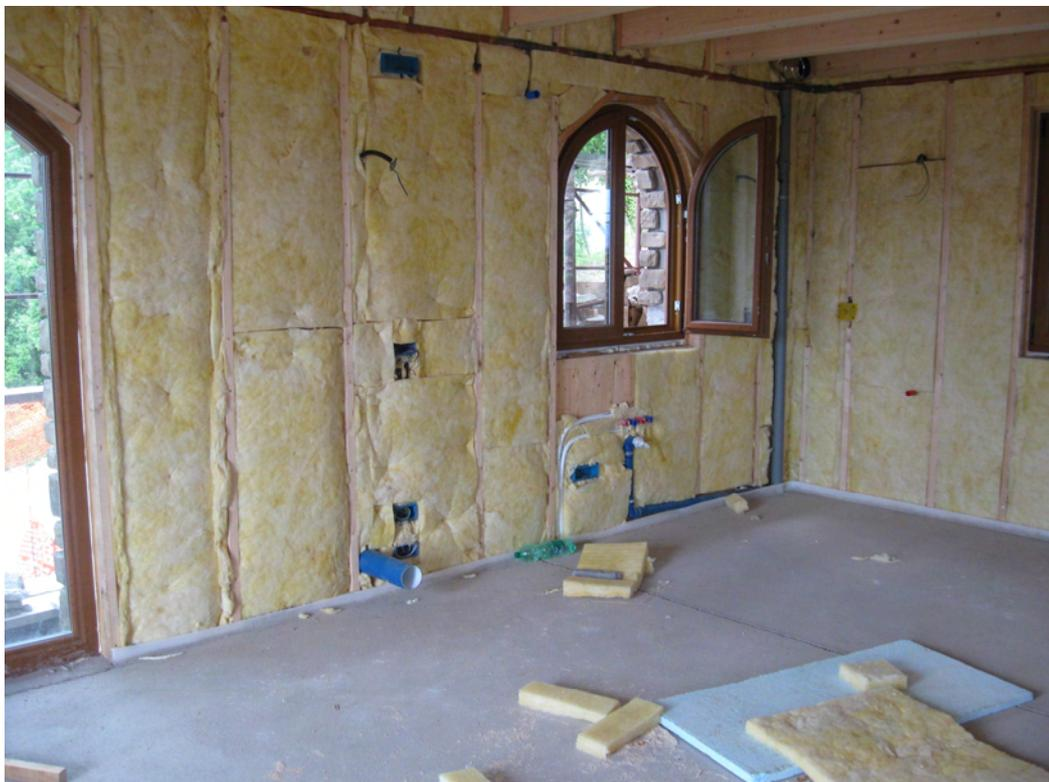
**Figura 65 – Posa del materiale isolante interno in lana di vetro.**
