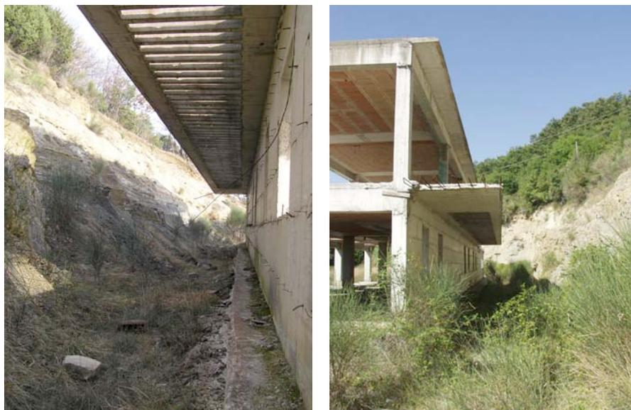
Rispetto al primo progetto, non è stata realizzata la struttura di collegamento tra il piano terra e il piano primo, ovvero i corpi scala. Si intravedono le tamponature strutturali dei vuoti che avrebbero occupato i rampanti di sbarco nonché il relitto di impronta del pilastro troncato, previsto a sostegno di detto corpo scala.
