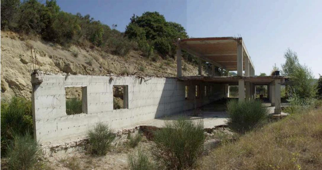
Il resto della struttura dall'altra parte della scarpata, è costituito invece da pilastri a sezione quadrata o rettangolare, gli stessi elevati in continuità dai plinti di fondazione e collegati alle travature orizzontali di collegamento (cordoli, travi orizzontali e ribassate).
