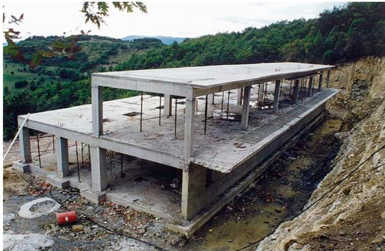
La struttura verticale si compone di pilastrature quadrate e rettangolari in pressoché continuità con quelle sottostanti agganciate alle fondazioni, mentre la copertura di tipo piano è costituita da un solaio in laterizio irrigidito da travetti "traliccianti" gettati in opera.
