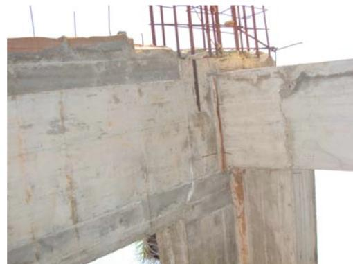
Nel lato a ridosso della scarpata si eleva in continuità un setto murario in ca dello spessore di 30 cm, ma troncato all'altezza dell'intradosso del primo solaio interpiano, nel quale sono state ricavate 8 aperture finestrabili non previste dal progetto iniziale.
